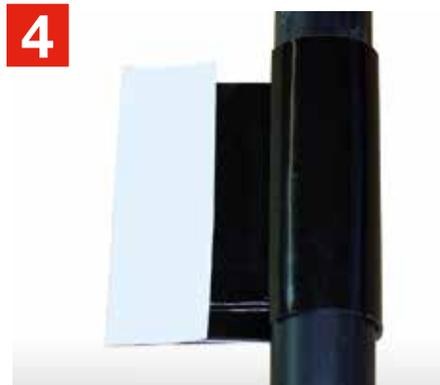
Transparente Trennfolie vom Reparaturband abziehen und Band unter leichtem Zug um die vorbehandelte Reparaturstelle aufbringen.
