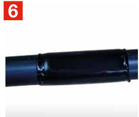
Der Schrumpfvorgang ist beendet, wenn das Band ohne Falten und Blasen umlaufend eng um die Reparaturstelle aufliegt und der Kleber beidseitig an den Kanten austritt.
