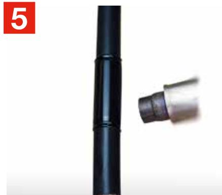
Reparaturband vom Bandende ausgehend über den gesamten Umfang mittels Heißluftpistole oder einer weich eingestellten Propangasflamme unter ständiger Bewegung zügig erhitzen.
