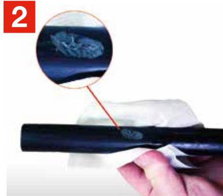
Mit dem Reinigungstuch Kabel im Bereich der Reparaturstelle umlaufend gründlich reinigen.
